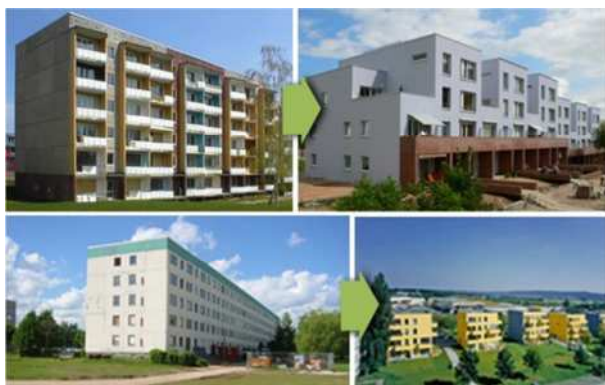
6.3. ábra Példa paneles épületek lehetséges rehabilitációjára: Leinefelde Németország
