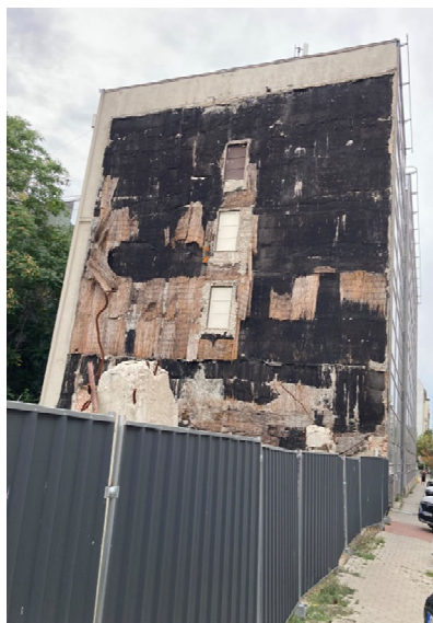
A szomszédos tűzfal a
