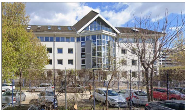
Az A Híd Zrt. irodaháza (forrás: Google Street View)
