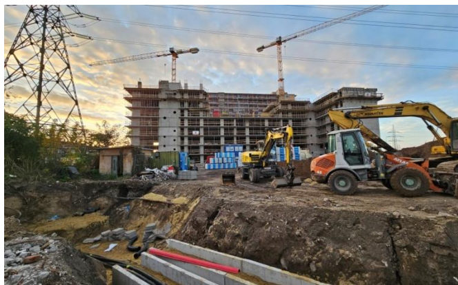
A New Palace kiváltásra szoruló távvezetéke új, földalatti nyomvonallal
