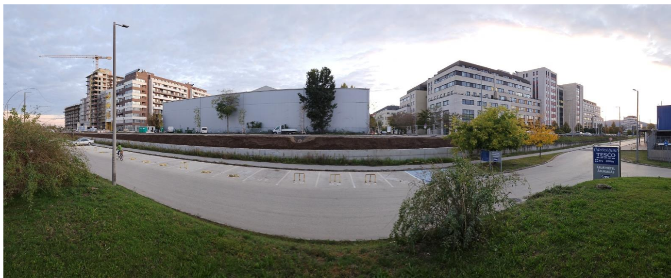
A 26035/11 hrsz-ú telken (projektterület) lévő raktárépület
