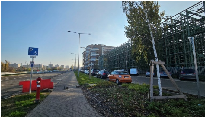
Útépitési munkálatok 2025 novemberében forrás: saját fotó
