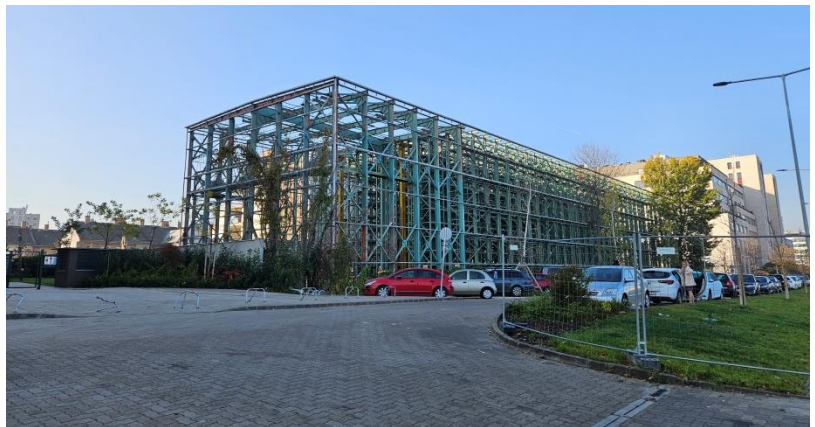
A projektterület melletti telken lévő korábbi Alexandra épületének bontási munkálata a Juta utca felől
