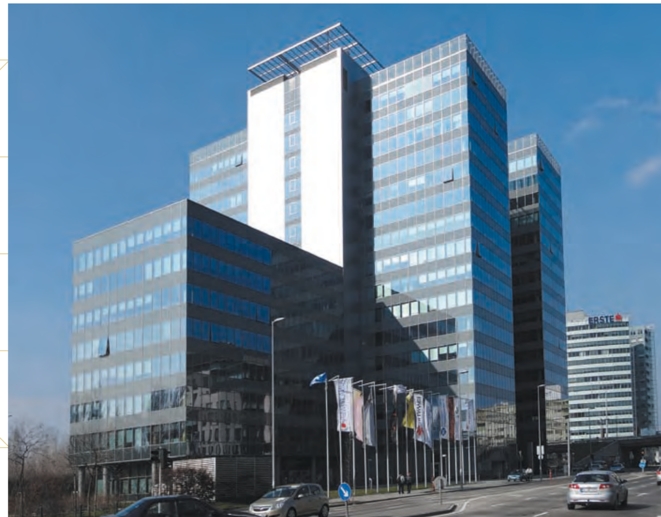
Duna Tower Irodaház
