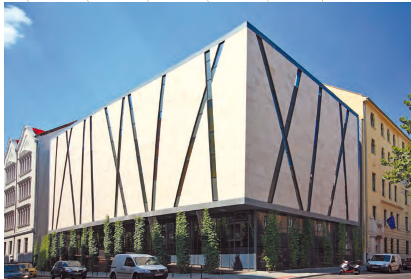
Pannónia Általános Iskola, tornacsarnok
