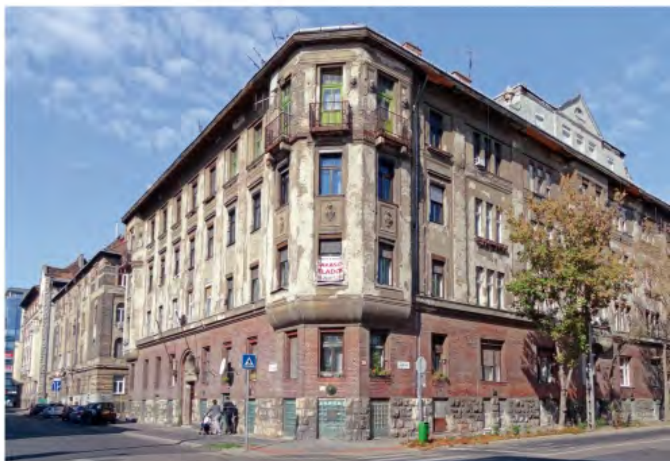
Lomb utca 18. LAKÓÉPÜLET 27793 hrsz. ÉPÍTÉS: Pollák Manó 1911.
