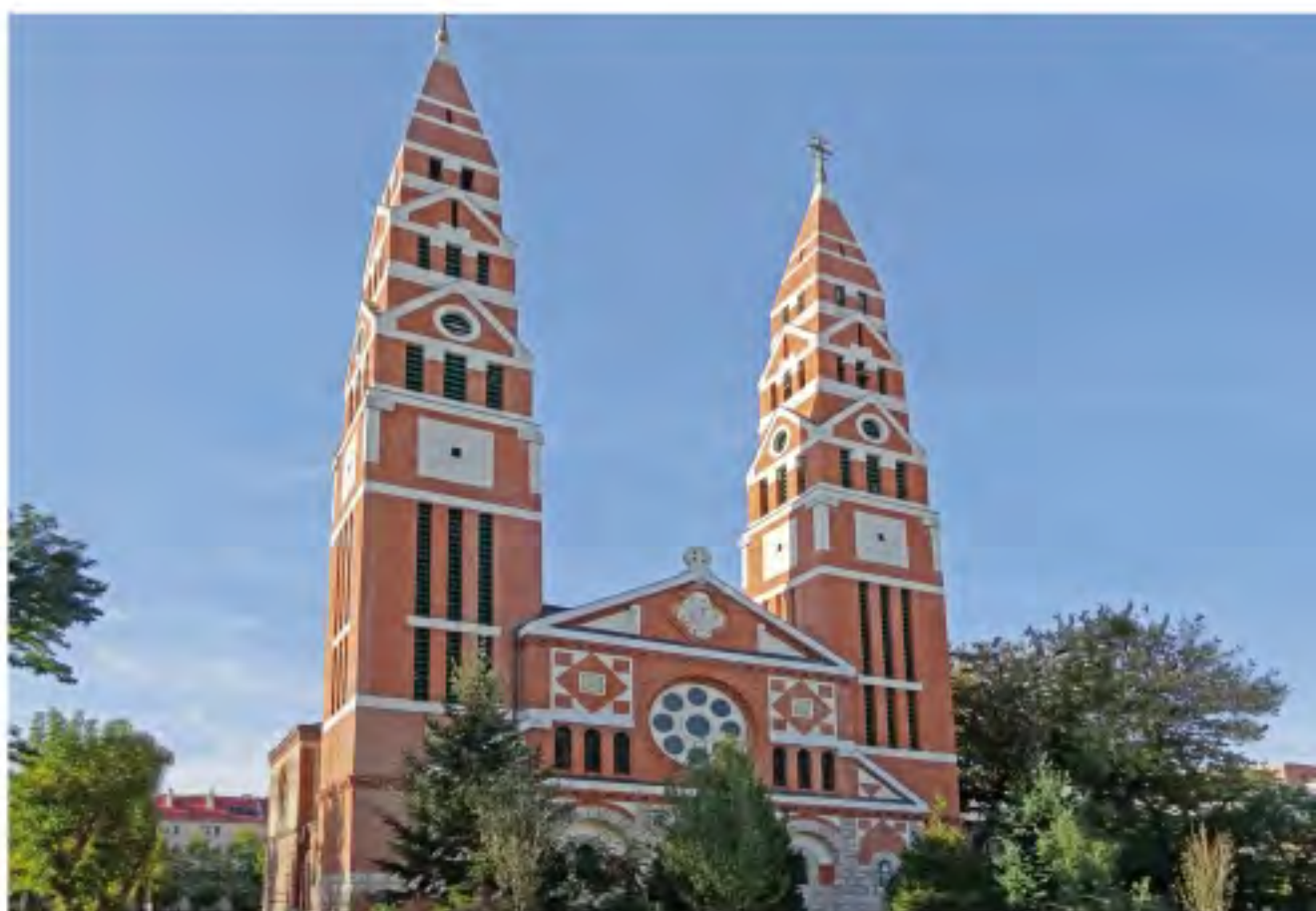
Babér utca 17/a-b. RÓMAI KATOLIKUS TEMPLOM ÉS PLÉBÁNIA 26085/172 hrsz. ÉPÍTÉS: Foerk Ernő 1930.
