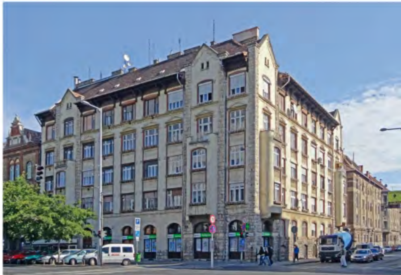
Váci út 87. LAKÓÉPÜLET 27793 hrsz. ÉPÍTÉS: Pollák Manó 1911.
