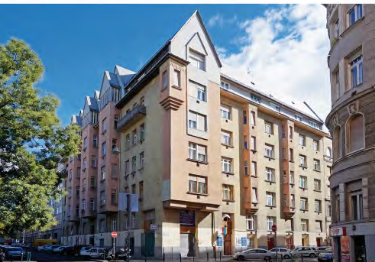
Balzac utca 8-10. LAKÓÉPÜLET, LÓRÁNT-HÁZ 25220 hrsz. ÉPÍTÉSZ: Ágoston Emil 1909-1910
