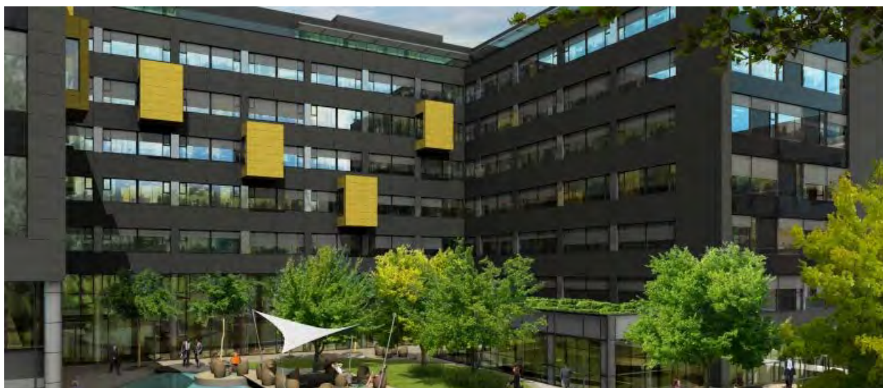
5. kép A 2013 márciusában átadott SKANSKA Green House, az első LEED tanúsítvánnyal rendelkező irodaház Magyarországon
